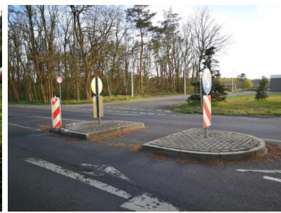
Querungshilfe: sicheres Überqueren der Fahrbahn für Fußgänger und Radfahrer
