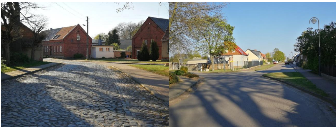
Abbildung 37: Straßenzustand in der Ortslage Insel (Luise-Mewis-Straße): links in Richtung Möringen im westlichen Teil mit schlechtem Zustand, rechts in Richtung Döbbelin mit der Einmündung Gohrer Weg – Zustand ok, in beiden Fällen: Fahren auf der Fahrbahn
