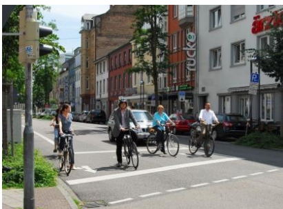
Aufgeweiteter Radaufstellstreifen (ARAS): Der Autoverkehr hält an der zurückgesetzten Haltelinie, der Radverkehr hat an der Lichtsignalanlage einen Vorteil und keine Abgase
