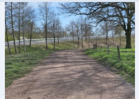
Nahrstedt: Weg am Dorfrand: Sand, tlw. grober Schotter, westlich Asphalt, Teilausbau (0,55 km)
