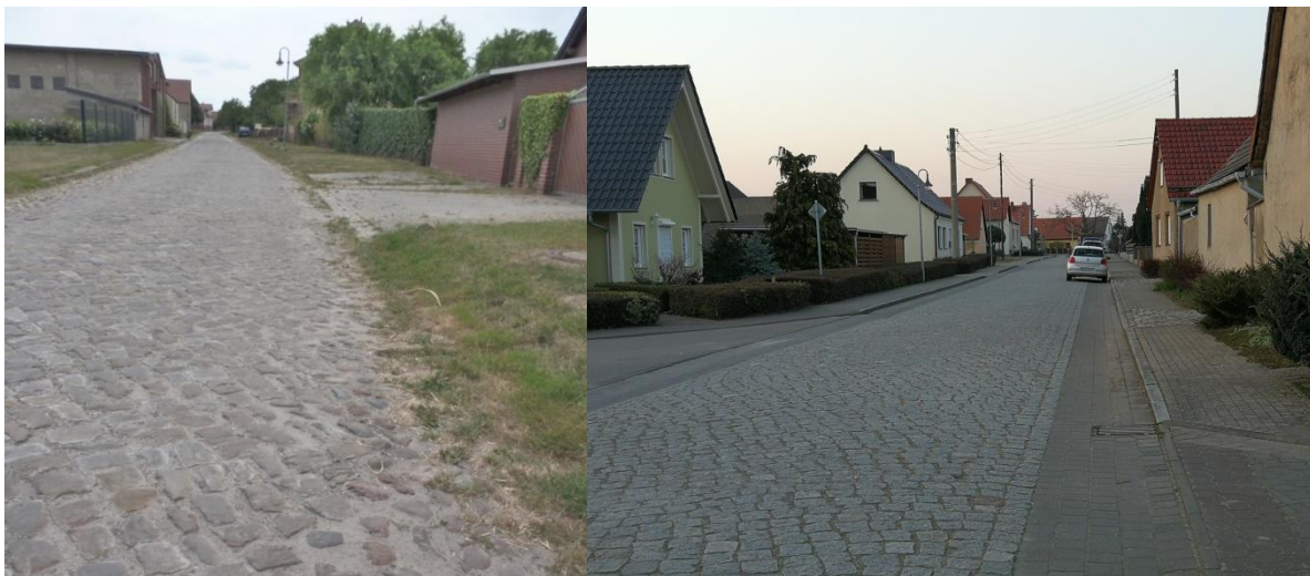
Abbildung 42: Dorfstraße Gohre – Schwierig mit dem Rad zu befahren Lösung Gartenstraße in Möringen: vergrößerter Radbereich beidseitig gepflastert mit Sicherheitsbereich zum Gehweg
