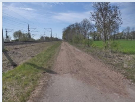
NA 03 Richtung Nahrstedt: teils grob geschottert, teils wassergebunden Ausbau notwendig (2,2 km)
