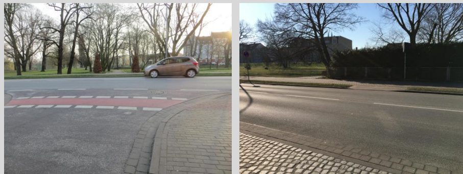
Abbildung 2.37: Fehlende Querungshilfen Stavenstraße & An der Rolle
