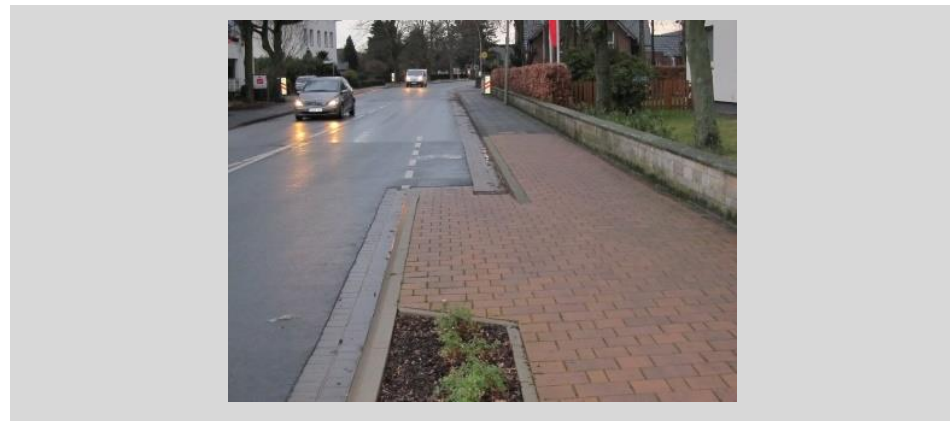
Abbildung 3.9: Beispiel für Übergang Radweg-Fahrbahn 38
