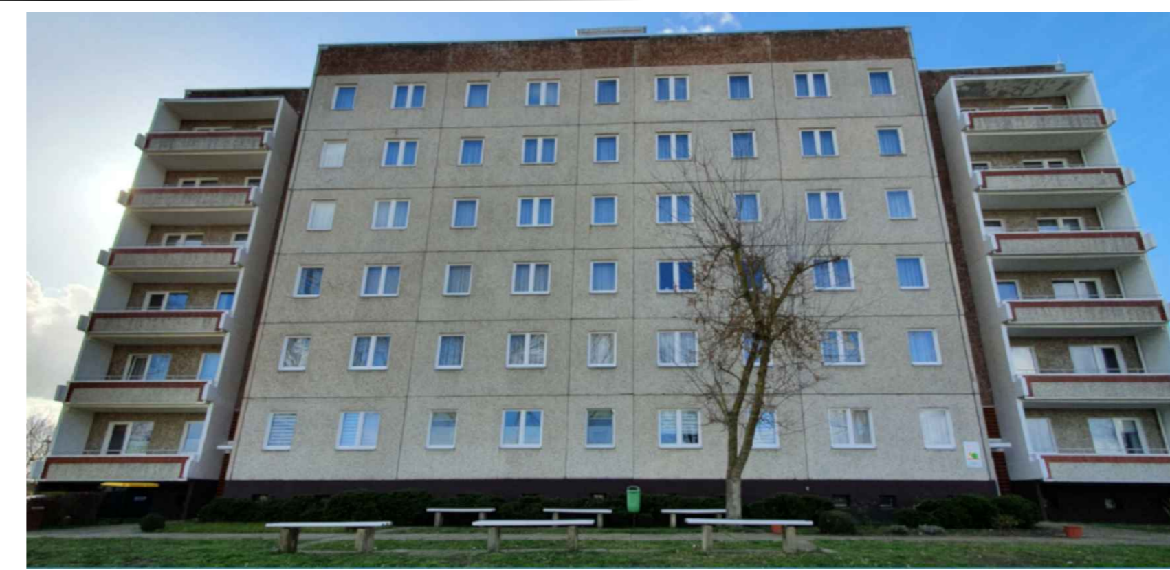
Industriestraße 20 a Haus I Ansicht Ost
