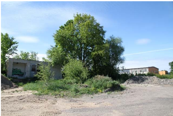
Alte Trafostation an der südlichen Grenze und Baumbestand auf dem Nachbargrundstück
