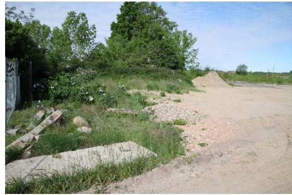
Eingangsbereich an der südlichen Grenze
