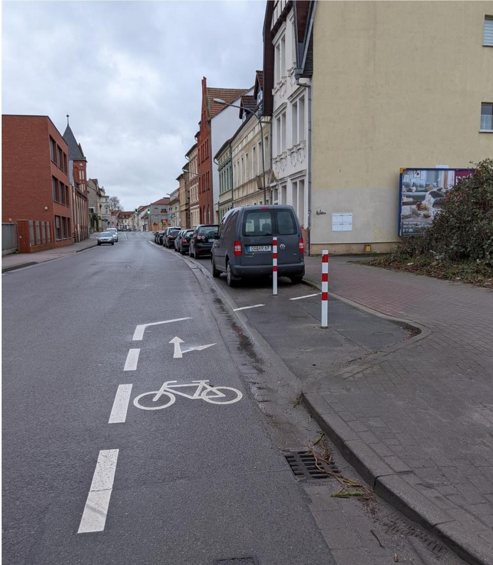
Diese Furt oder Weiche zeigt an, dass entweder auf der Fahrbahn weiter gefahren werden kann oder aber auf den nicht benutzungspflichtigen Radweg auf dem Seitenstreifen gefahren werden kann. Für den Übergang wurde ein Parkplatz umgewidmet
