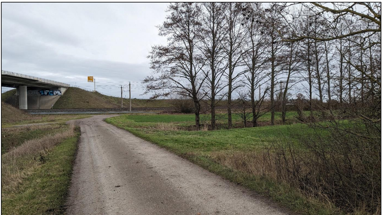
Fotoaufnahme 16: Teilfläche 2 teilweise einsehbar, teilweise Sichtschutz durch Baumreihe, PVA fügt sich neben bereits bestehende bauliche Elemente (ICE-Trasse, Bundesstraße, Betonspur, Brücke, Hochspannungsleitung) ein
