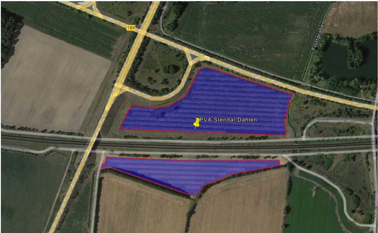
Bild 2.1.2: PV Anlage, Bahnstrecke, Bundesstraßen (Quelle: SolPEG)
