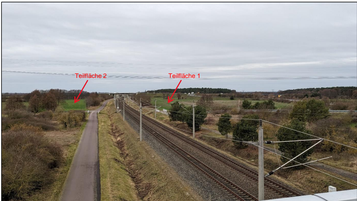
Fotoaufnahme 8: Teilfläche 1 und 2 teilweise einsehbar, teilweise Sichtschutz durch bestehende Gehölze, PVA fügt sich neben und zwischen bereits bestehende bauliche Elemente (ICE-Trasse, Bundesstraße, Betonspur, Brücken) ein
