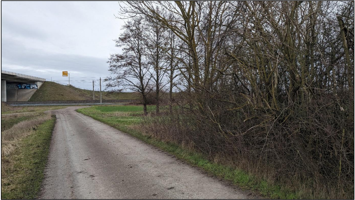
Fotoaufnahme 15: Teilfläche 2 teilweise einsehbar, teilweise Sichtschutz durch Hecke und Baumreihe, PVA fügt sich neben bereits bestehende bauliche Elemente (ICE-Trasse, Bundesstraße, Betonspur, Brücke, Hochspannungsleitung) ein
