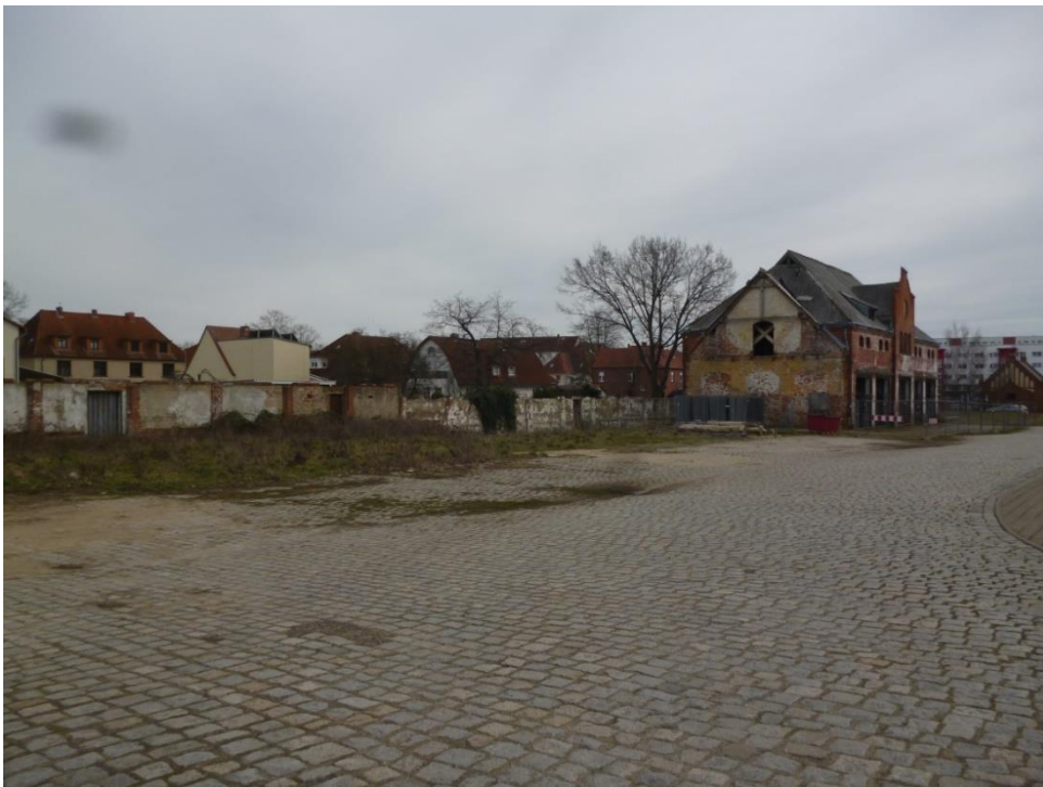
Blick in Richtung Südosten zur Gneisenastraße
