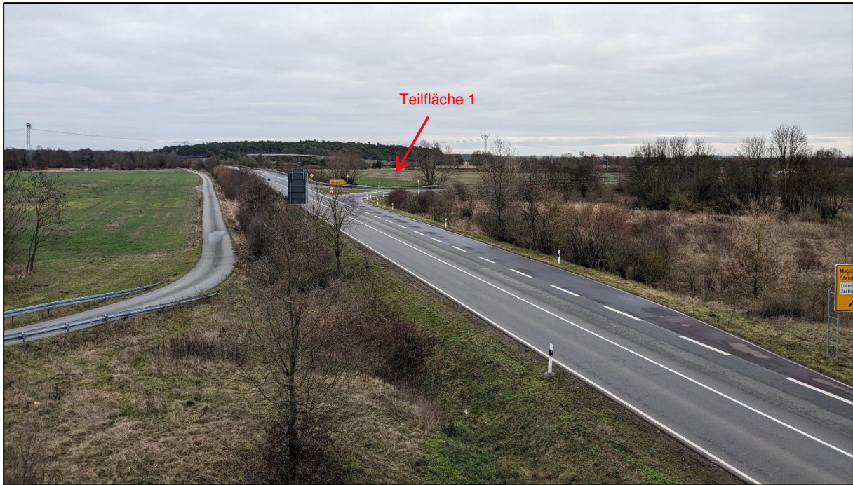
Fotoaufnahme 1: Teilfläche 1 teilweise einsehbar, teilweise Sichtschutz durch bestehende Gehölze, PVA fügt sich zwischen bereits bestehende bauliche Elemente (Bundesstraße, Beschilderung, Brücke) ein
