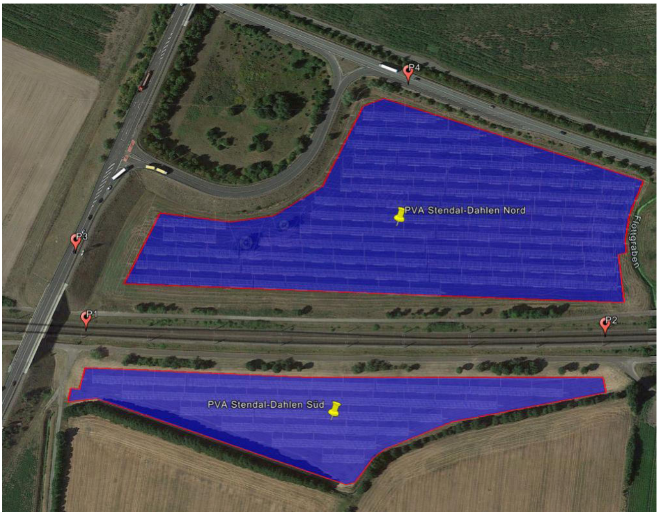
Bild 3.5.1: Exemplarisch gewählte Messpunkte (P1- P4) für die Analyse der Reflexionen (Quelle: Google Earth/SolPEG)
