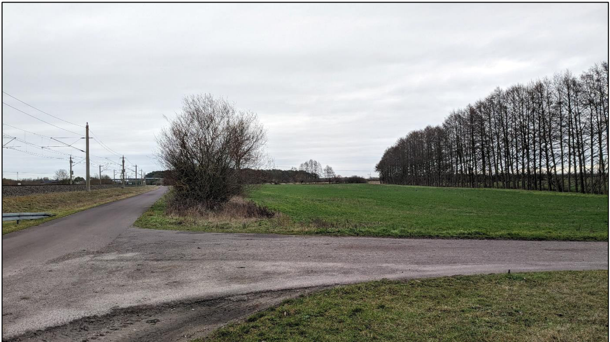
Fotoaufnahme 14: Teilfläche 2 einsehbar, PVA fügt sich neben bereits bestehende bauliche Elemente (ICE-Trasse, Bundesstraße, Betonspur, Brücke, Hochspannungsleitung) ein
