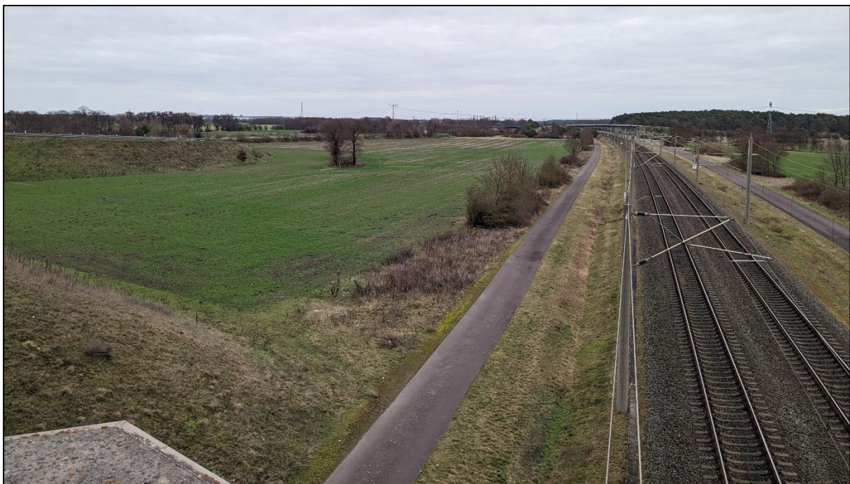
Fotoaufnahme 2: Teilfläche 1 einsehbar von der Bundesstraßenbrücke, PVA fügt sich zwischen bereits bestehende bauliche Elemente (Bundesstraße, ICE-Trasse, Brücke, Hochspannungsleitung) ein
