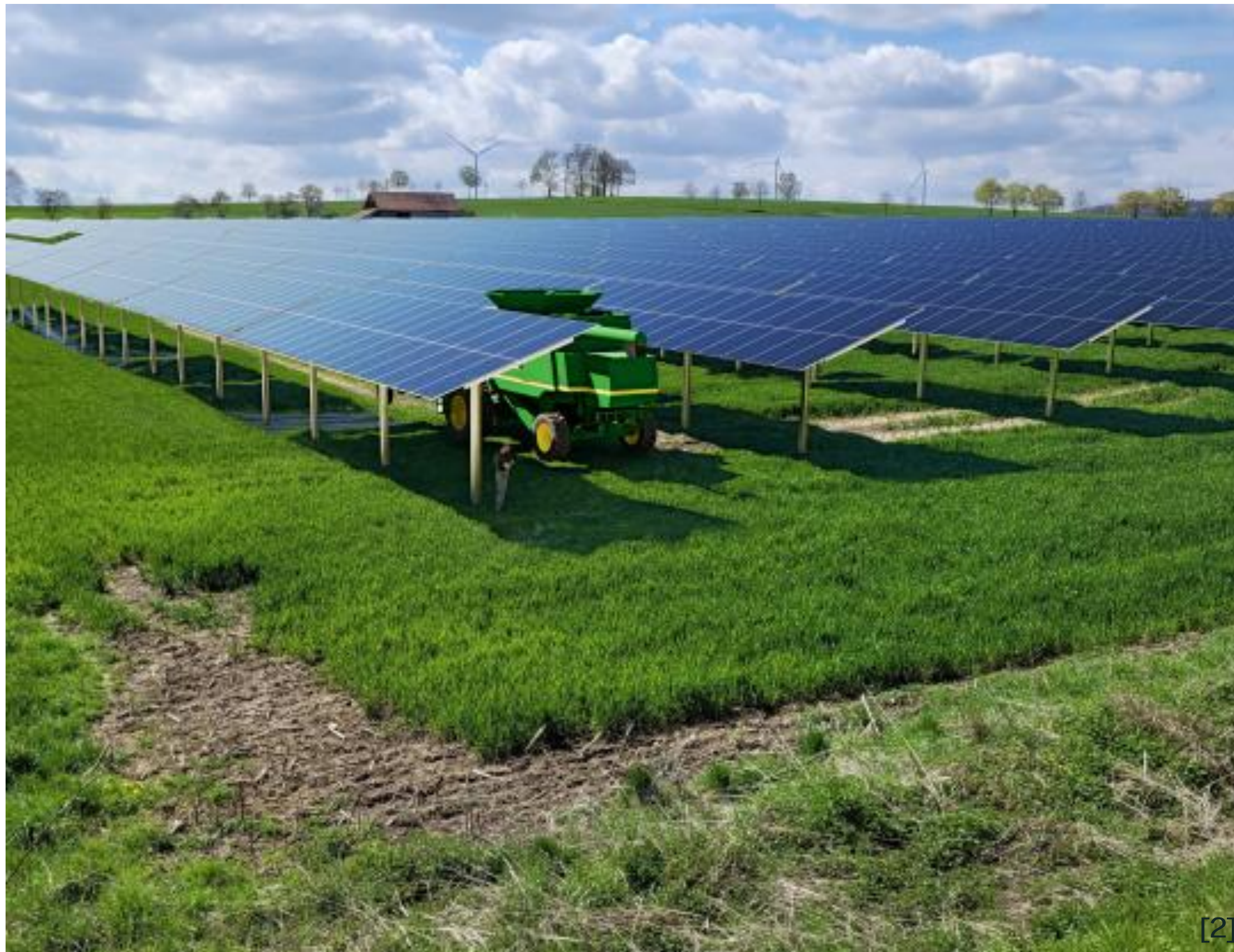
Bild: Agri-PV Anlage mit Trackern und einer Bewirtschaftung zwischen den Modulreihen
