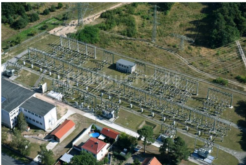
Luftbild: Umspannwerk Stendal (Gardelegener Straße)
