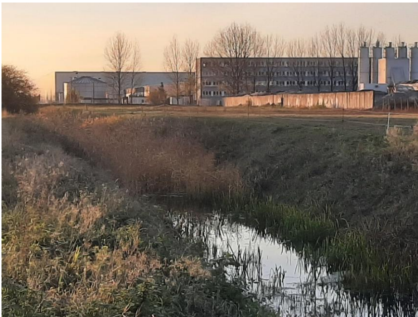
Abb. 6: Begradigter Flottgraben mit Trapezprofil im Plangebiet
