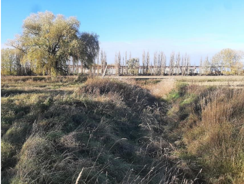
Abb. 5: Begradigter Rohrwiesengraben ohne nennenswerte Wasserführung
