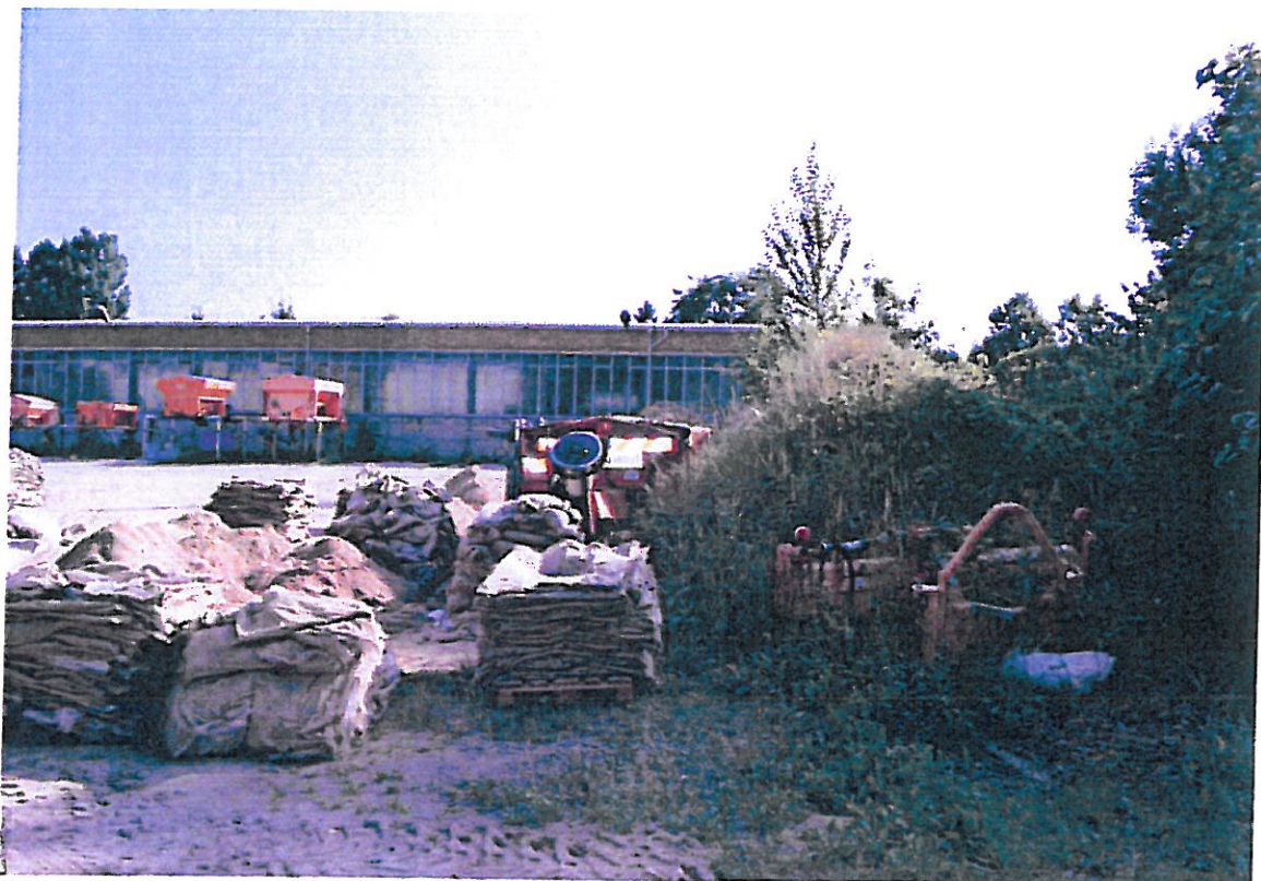
vorhandenes Freilager, im Hintergrund zu sanierende Werkstatthalle
