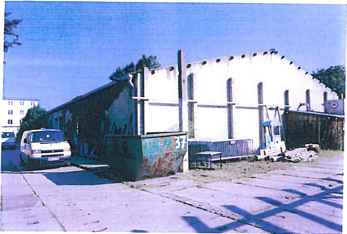
alte Schlosserei und Tischlerei, soll zurückgebaut werden
