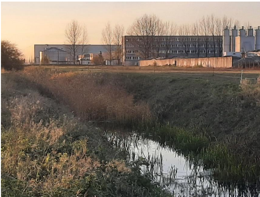
Abb. 6: Begradigter Flottgraben mit Trapezprofil im Plangebiet
