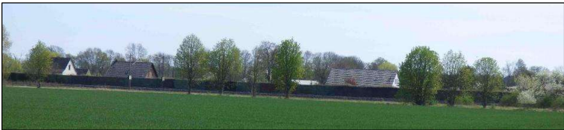
Abb. 18 Schallschutzwand im Bereich der Wohnbebauung Tornau in Richtung Süden
