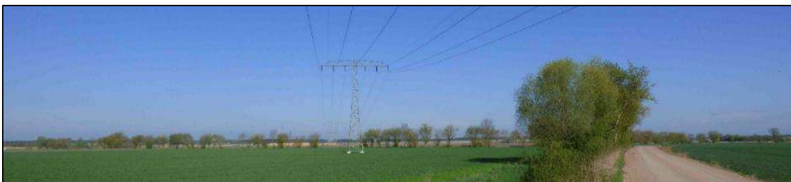
Abb. 20 Freileitung innerhalb des südwestlichen Bereichs der TF 2
