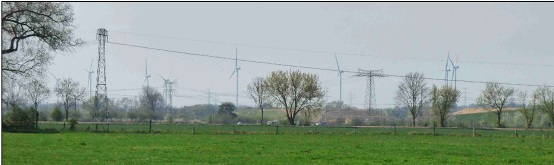
Abb. 17 Bahnstrecke mit Baustelle Autobahntrasse, Freileitung und Windkraftanlagen in Richtung Süden und Westen
