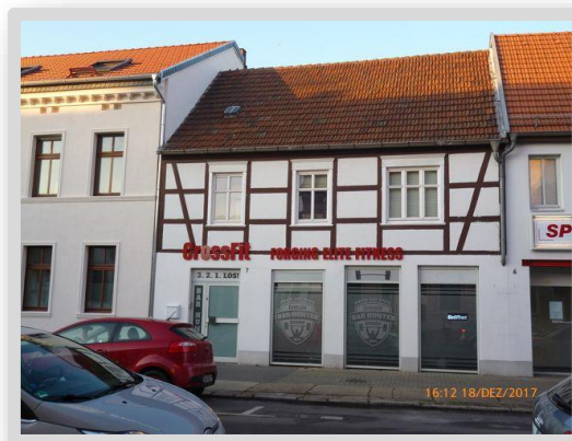
Abbildung 18 - Rathenower Straße 7 vor und während Umbau
