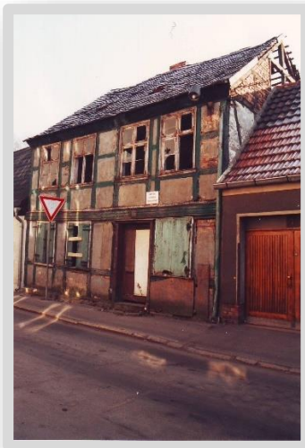
Abbildung 3 - Vogelstraße 8 vor dem Abriss
