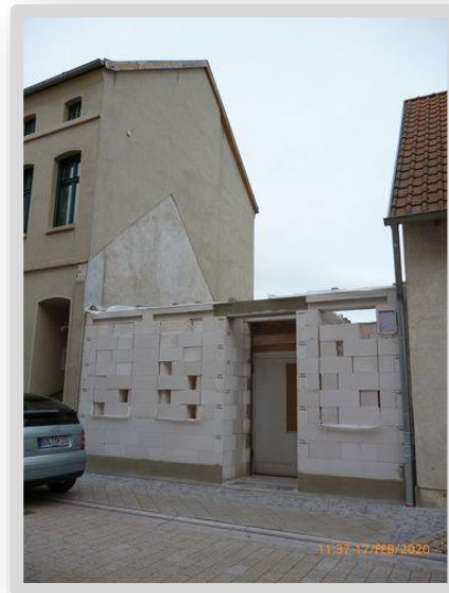
Abbildung 52 - Stavenstraße 15 - während Bau
